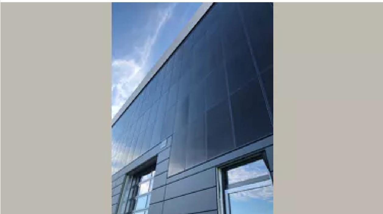
**Immagine 4: Il lato soleggiato: grazie ai moduli fotovoltaici Solarwatt fissati in modo permanente e sicuro alla facciata del suo nuovo edificio, Fenecon potrà beneficiare di questa forma alternativa di produzione di energia per decenni a venire, con il vantaggio di bassi costi operativi e un migliore impronta di carbonio.**
