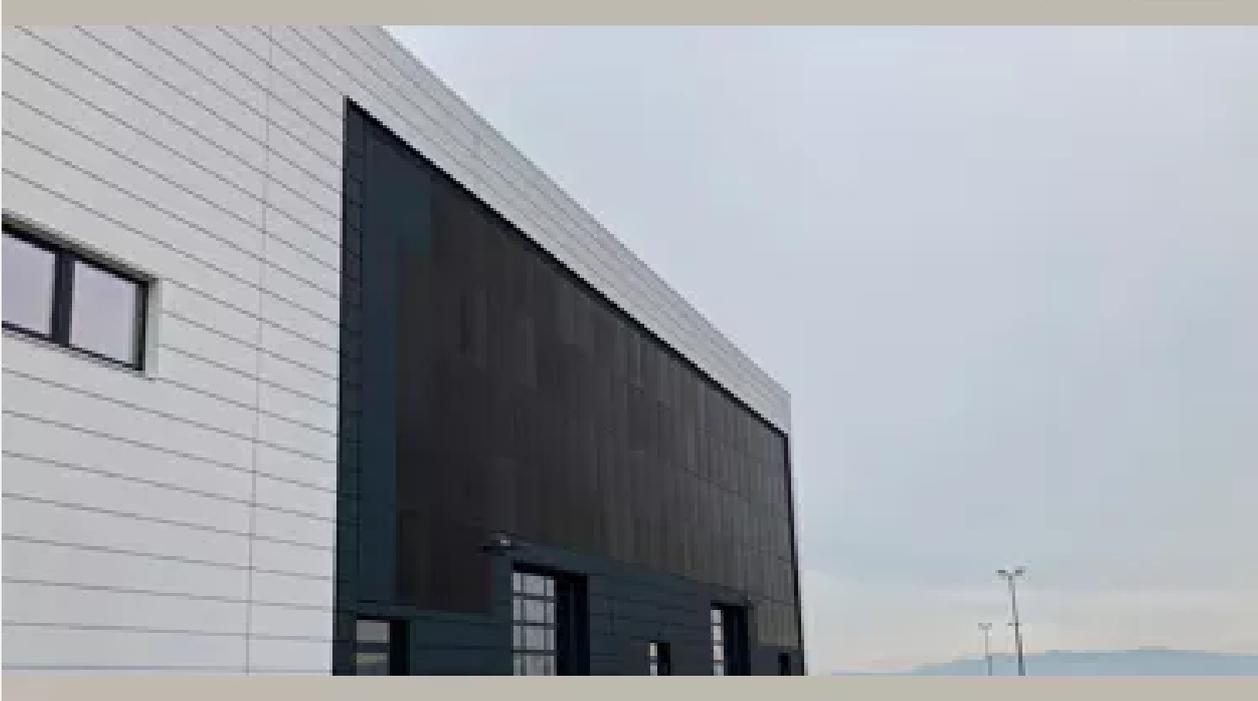
**Immagine 3: Moduli fotovoltaici su larga scala: la facciata solare del nuovo edificio di produzione, sviluppo, logistica e uffici di Fenecon a Iggensbach (Baviera) rende l'edificio più sostenibile ed economico per funzionare attraverso la produzione di energia alternativa dall'energia solare. I moduli fotovoltaici sono stati fissati in modo permanente e sicuro alla facciata con una soluzione di sottostruttura di fischer BWM Fassadensysteme.**
