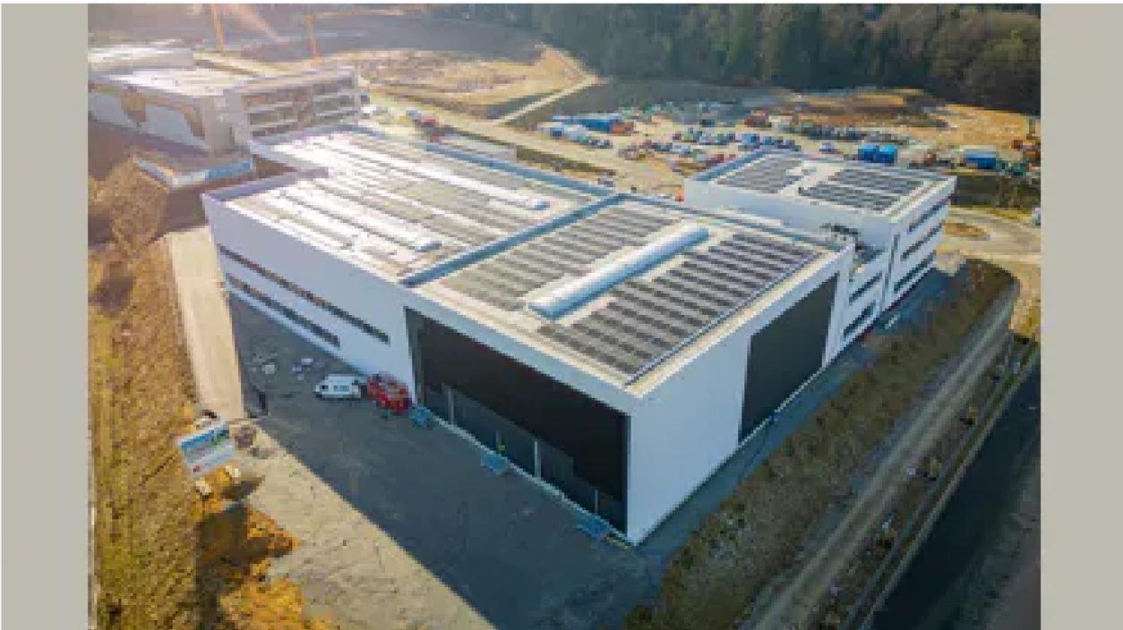
**Immagine 1: Moduli fotovoltaici su larga scala: la facciata solare del nuovo edificio di produzione, sviluppo, logistica e uffici di Fenecon a Iggensbach (Baviera) rende l'edificio più sostenibile ed economico per funzionare attraverso la produzione di energia alternativa dall'energia solare. I moduli fotovoltaici sono stati fissati in modo permanente e sicuro alla facciata con una soluzione di sottostruttura di fischer BWM**
