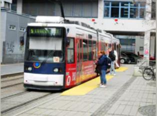
**Immagine 2: Salite tutti, per favore: con i sistemi di rampe modulari Fisco a Jena vengono compensate le differenze di altezza di 3 cm e 5 cm tra la piattaforma e il tram, in modo che anche i passeggeri con mobilità ridotta possano raggiungere la loro destinazione facilmente e in sicurezza. Le soluzioni di sistema garantiscono l'accessibilità anche alle fermate irregolari e con raggi convessi e concavi.**
