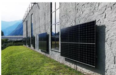
**Il progetto di efficientamento energetico ha previsto l'installazione di quinte fotovoltaiche che si alternano alle vetrate, su una struttura di montanti verticali e orizzontali fissati direttamente sul rivestimento delle pareti.**
